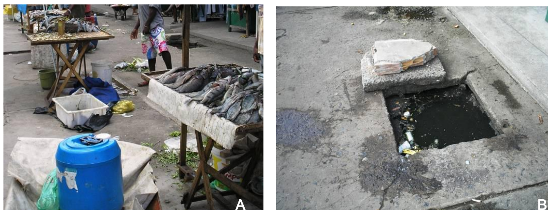
Figura 11 (A e B) – A - Restos de alimentos jogados indistintamente no chão; B - Tampão de esgoto aberto.
