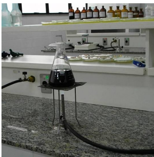
Figura 21 - Tubulação de gás e Bico de Bunsen
