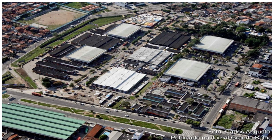
Foto 10 – Vista Aérea do Centro de abastecimento em 2018.
