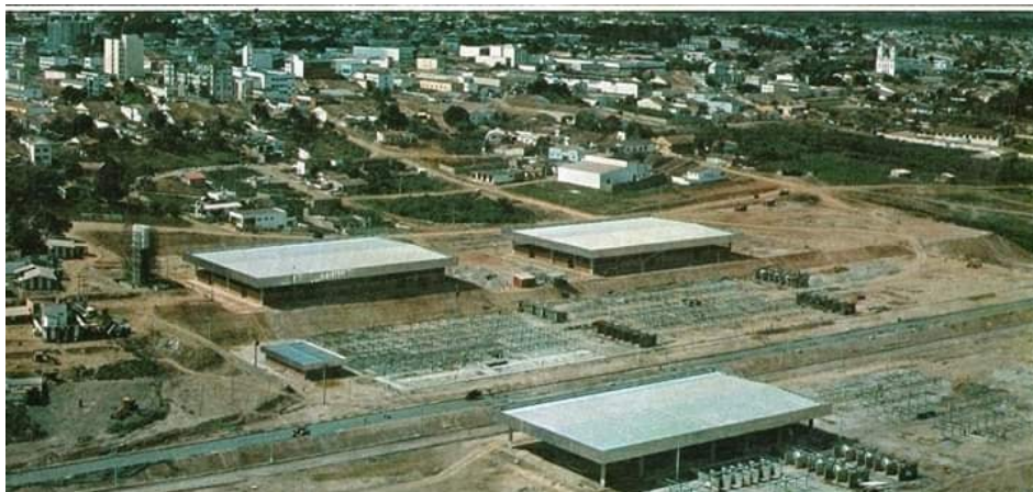
Foto 9 – Centro de Abastecimento em fase de Construção – 1975.
